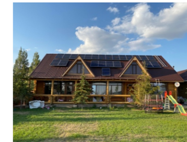
Казахстан / on grid Мощность: 10 кВт Тип: сетевая станция
