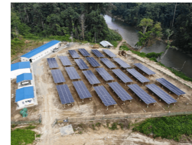
Малайзия / utility Мощность: 2,4 МВт Тип: гибридная станция
